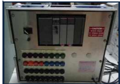
Allen Bradley SLC 5/03
